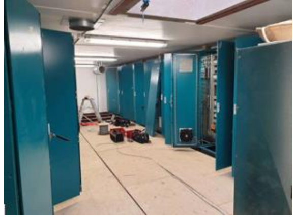
Paneler under installation fra Støvring Kraftvarmeværk
