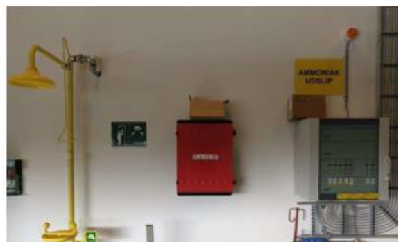
(Sikkerhed) sikkerheds-station under opførelse, akustisk og visuel alarm advarer i tilfælde af kølemiddeludslip
