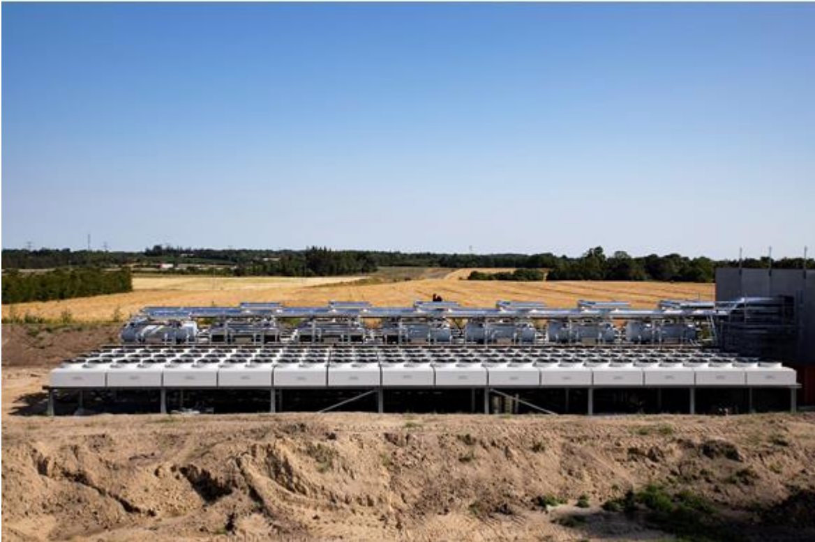
56 luftkølere opført hos Støring Kraftvarmeværk
