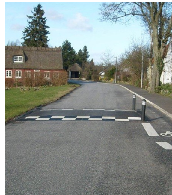
Kærvej - Armaturer af typen Milewide
