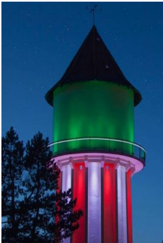
Vandtårn i Rødovre med julebelysning designet af ÅF Lighting A/S
