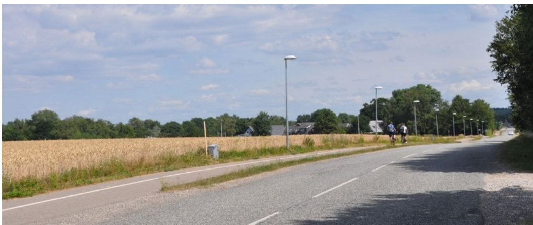
Belysning af sti langs trafikvejen Lyngvej med armaturer af typen Iridium. Cykelstien er en vigtig skolesti.
