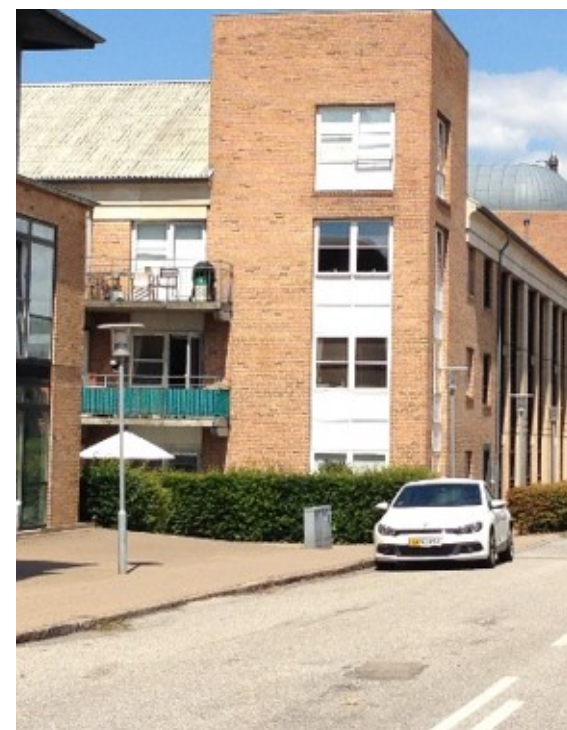
Prins Valdemars Alle med både enfamiliehuse og etagebyggeri. Parklygter er af typen Albertslund.
