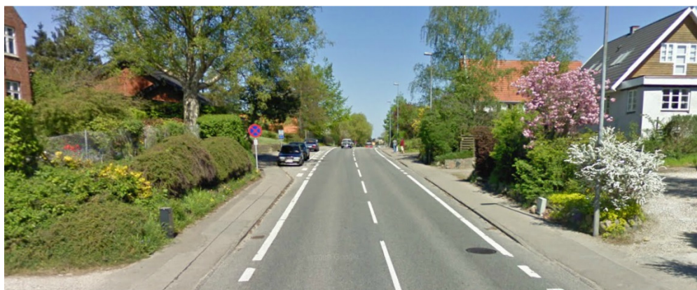
Figur 5. Delstrækning 2. Bemærk p-lommen til venstre i billedet.
