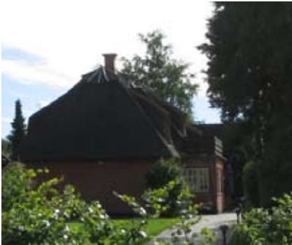
Lille Bløvsrødvej 20 er udpeget som bevaringsværdig.
