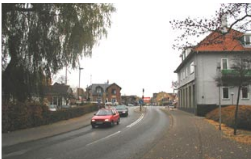
Eksisterende bygning for Lokalbanken, Frederiksborgvej 25
