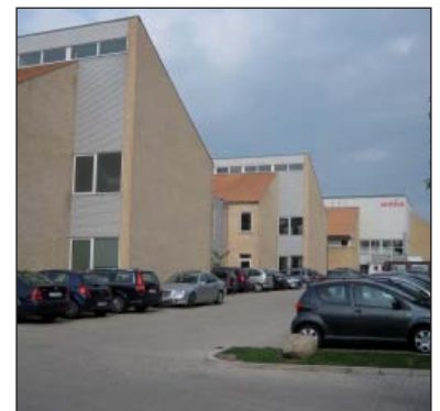
Tilbygninger fra 2004. I baggrunden ses hovedbygningen
