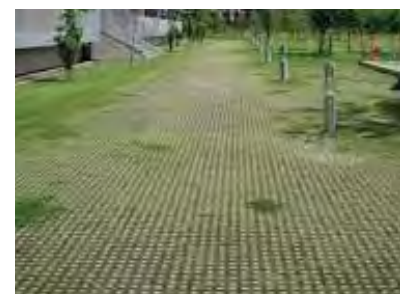
Armeret græs : Parkeringspladserne får en bund af armeret græs, hvilket er med til at forstærke områdets grønne karakter.
