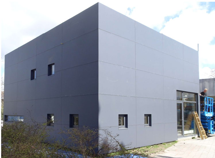
Efterisolering af facade, Engholmskolen
