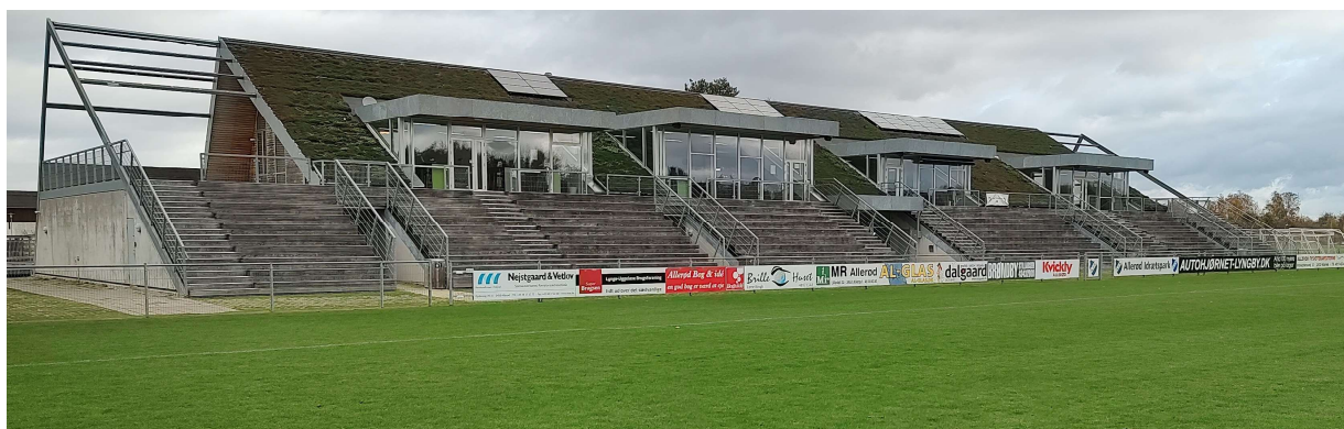
Jordvarmeanlæg – Allerød Idrætspark
